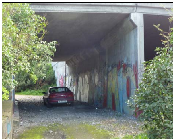
Kulvert under Dokkveien, sett fra nord (Øst for Munkedamsveien)
