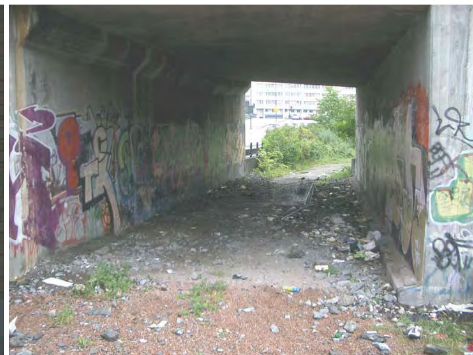
Kulvert under Dokkveien planlagt og bygd som hovedsykkelvei langs Munkedamsveien.
